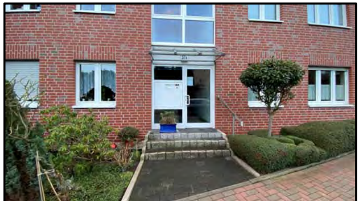
Eingangsbereich zum Gebäudeteil „Eickenhof 37 a“
